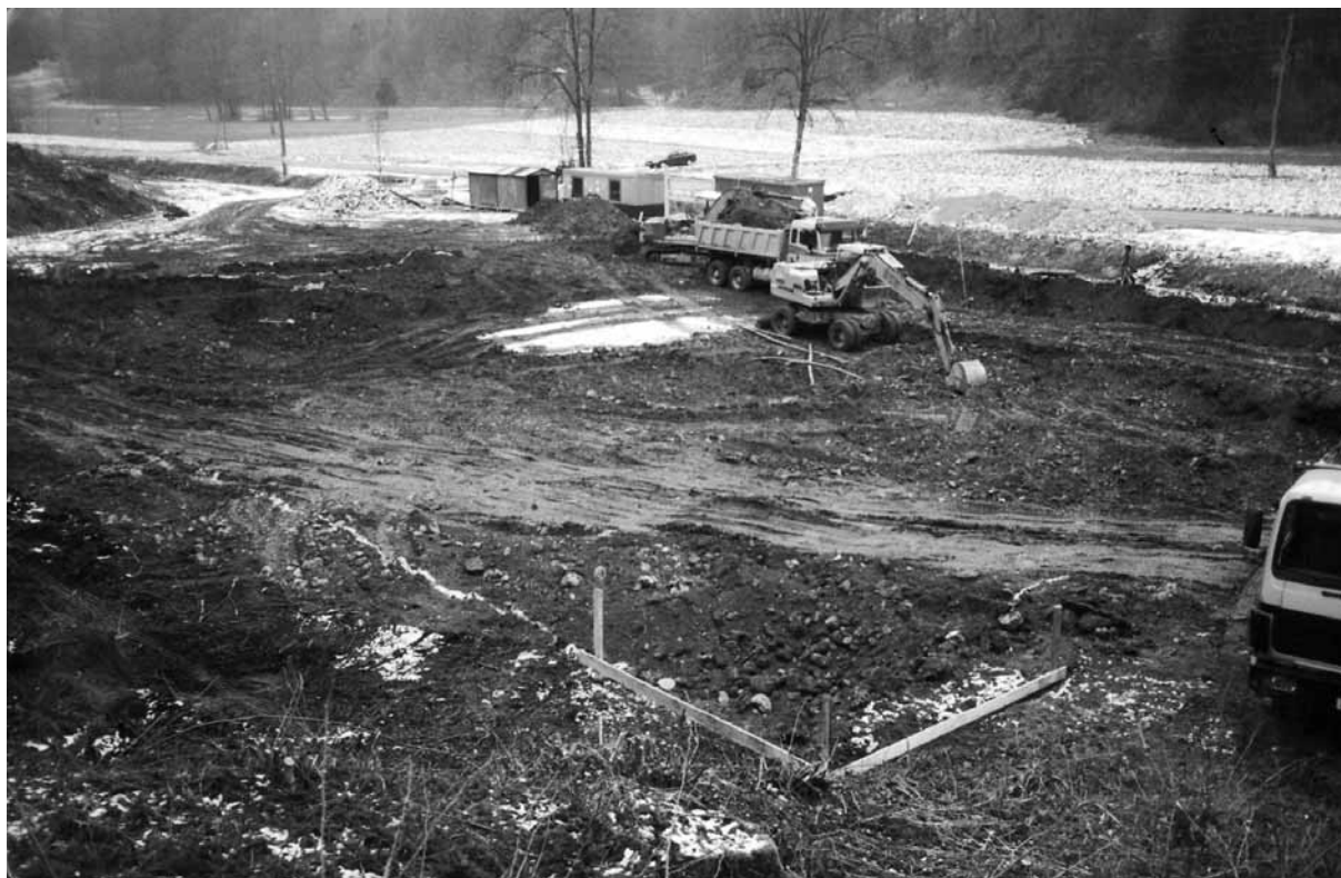
Januar 2001 - začetek gradnje bazena (Foto: arhiv Ivana Hribarja)
