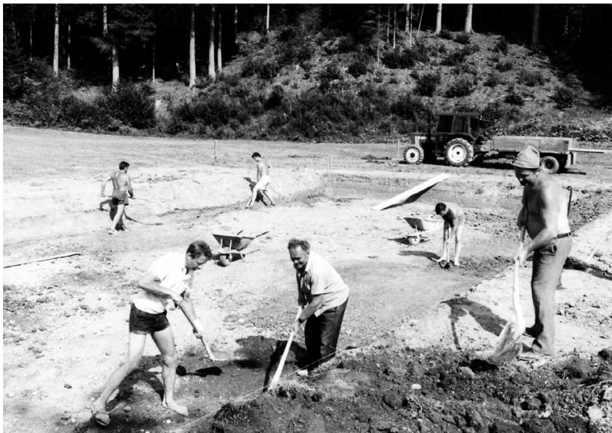
Gradnja pilotnega bazena v Snoviku (Foto: arhiv Ivana Hribarja)
